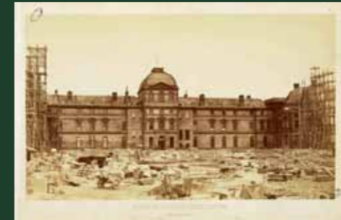
Chantier de la cour Napoléon, façade ouest du Vieux Louvre. Photographie d'Edouard Baldus, vers 1854-1855 [Arch. nat., 64A/264/1].
