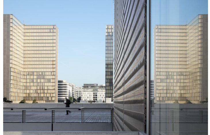
▲ © Eric Sempé / BnF. Architecte D.Perrault, © ADAGP, 2014
